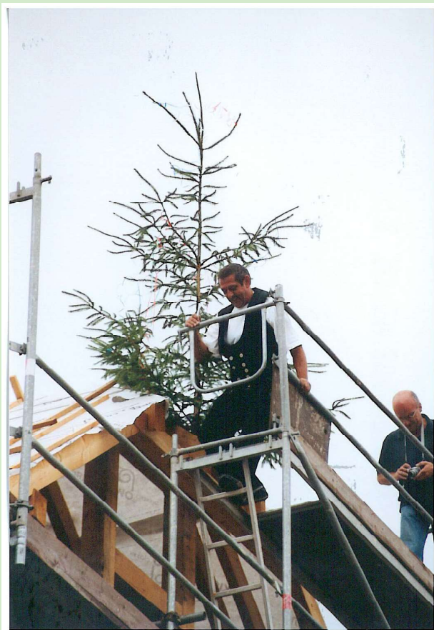
Richtfest bei Sanierung Schillerstraße 2
