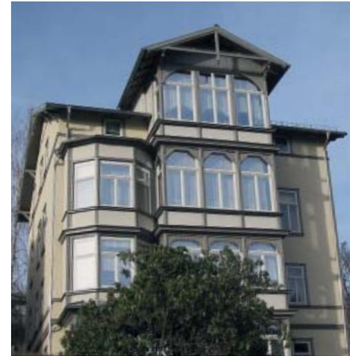
Wiederherstellung und Ergänzung der talseitigen, vollverglasten Veranden, nach historischem Vorbild, bergseitig filigrane Stahlbalkone eingefügt, Dacheindeckung mit anthrazitfarbenen Tonziegeln matt engobiert, Ortgang an der talseitigen Veranda wurde wieder in bauzeitlicher Gliederung mit Freigespärre freigelegt, Farbgebung erfolgt aus dem Gestaltungsprinzip der Fassade: dunklerer Rahmen für die tragenden Teile, hellere Füllungen z.B: für Brüstungsfelder der Veranden
