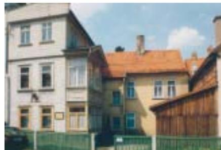
Zwei- bis dreigeschossiges Gebäudeensemble: umfassende Sanierung, auch des prachtvollen, typischen Wintergartens, Einbau von gegliederten Holzfenstern und -türen, Wiederherstellung von feingliedrigen Fensterläden, gestaltete Putzfassade in Pastelltönen, Eindeckung des Daches mit naturroten Tonziegeln
