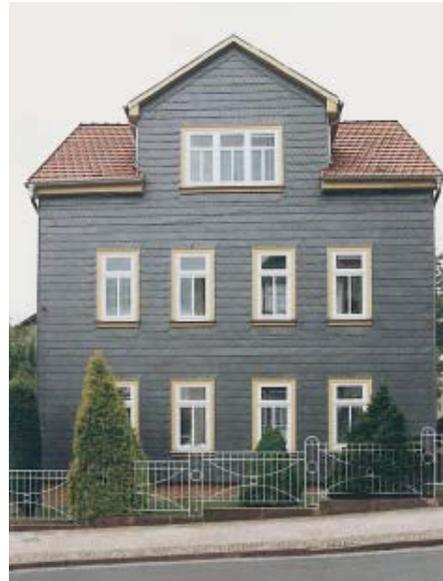
Zweigeschossiges Wohnhaus mit ausgebautem Dachgeschoss, sichtbar an großem Zwerchhaus, im Rahmen der Sanierung wurden gegliederte Holzfenster mit Holzbekleidungen und kleinformatiger Naturschieferbehang der Straßenfassade erneuert, bemerkenswert ist der schlicht gegliederte Metallzaun, Gebäude und Zaun bilden eine gestalterische Einheit
