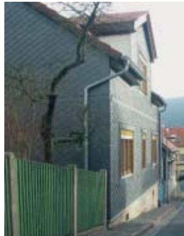
An diesem gut proportionierten Wohngebäude mit Zwerchhaus zur Neuen Straße wurde die Plattenverkleidung zugunsten einer gegliederten und kleinformigen Naturschieferverkleidung entfernt. Ergänzt wurden die Arbeiten durch den Einbau gegliederter Holzfenster.
