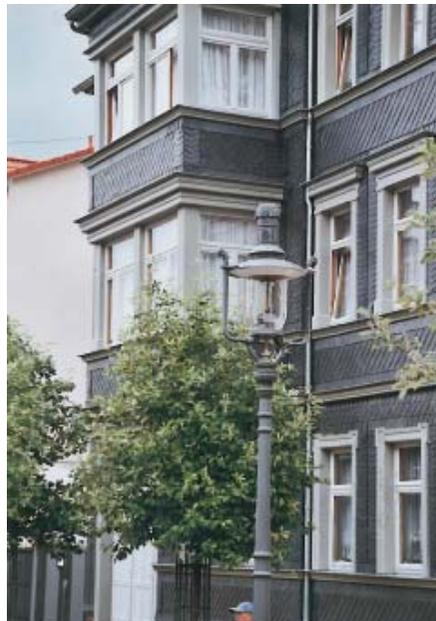
2001/2002 fand eine umfassende Sanierung der reich gegliederten Straßenfassade statt, mit Wiederherstellung der gegliederten Gesimse und Bekleidungen, der kleinformatigen Naturschieferfassade, hier im Spitzwinkelformat mit Orten und Gebinden an allen Fassadenöffnungen, Anstricharbeiten der vorhandenen Holzbauteile ergänzten die Arbeiten, die zu einem überzeugenden Ergebnis kamen.
