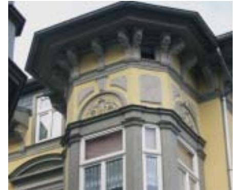
unter dem Dachabschluss in grauen Farbtönen, eingebettet in eine gelbe mineralische Putzfassade. Die Fenster wurden in Holz als zweiflügelige Stulpfenster mit separat offenbarem Oberlicht ausgebildet, die Türen werk- und maßstabgerecht hergestellt bzw. sanierungsfähige wurden erhalten. Der Natursteinsockel wurde aufgearbeitet.
