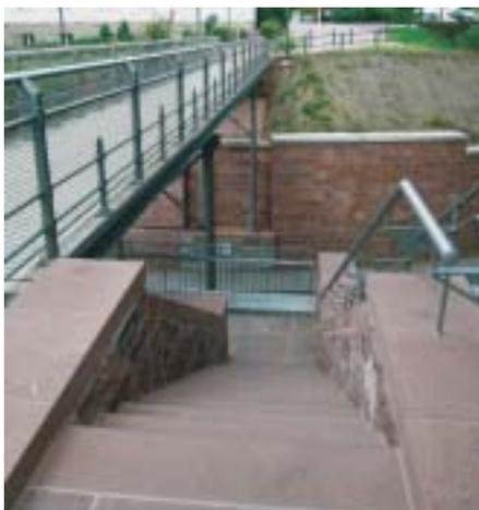
steinmaterial verwendet, für die Treppelläufe und Podeste Werkstein. Die gesamte Natursteinkonstruktion wurde als Verblendmauerwerk zum großen Teil selbsttragend mit zusätzlichen Verankerungen vor und auf einer Betonunterkonstruktion errichtet. Zum Versatz und zur Verfügung der Werksteinkonstruktion wurden ausschließlich hochsulfatbeständige Mörtelsysteme zum Einsatz gebracht, um eine weitestgehende Resistenz gegenüber der unvermeidbaren Belastungen aus Auftausalzen zu erreichen.
