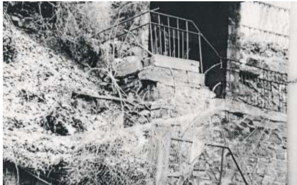
gen, Einstürze und Totalverluste der Treppenläufe. Mauern glitten zum großen Teil am Hang ab, folglich entstanden erheblichen Schäden an den Metallbrüstungsgittern in Form von Deformierungen, Abbrüchen und Totalverlusten.
