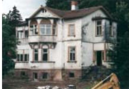
und Gebinde, talseitige, reich gegliederte Veranda, verzierte Balkenköpfe sowie Zierelemente aus Holz umlaufend am gesamten Gebäude unterhalb der Traufzone, gegliederte Holzfenster, profilierte Holzbekleidungen, Sanierung des Natur-
