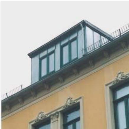
*Neue Gaube mit flachgeneigtem Dach und Blechverkleidung nimmt die Achsialität der Fenster auf, Traufdachkasten blieb erhalten*
