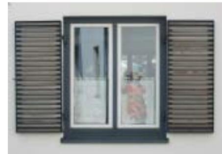
*Holzfenster in Massivbau mit modernen Holzfensterläden in Stahlrahmen, Fensterflügel und Blendrahmen mit Stulpdeckleiste haben unterschiedliche Farben, damit filigrane Wirkung*
